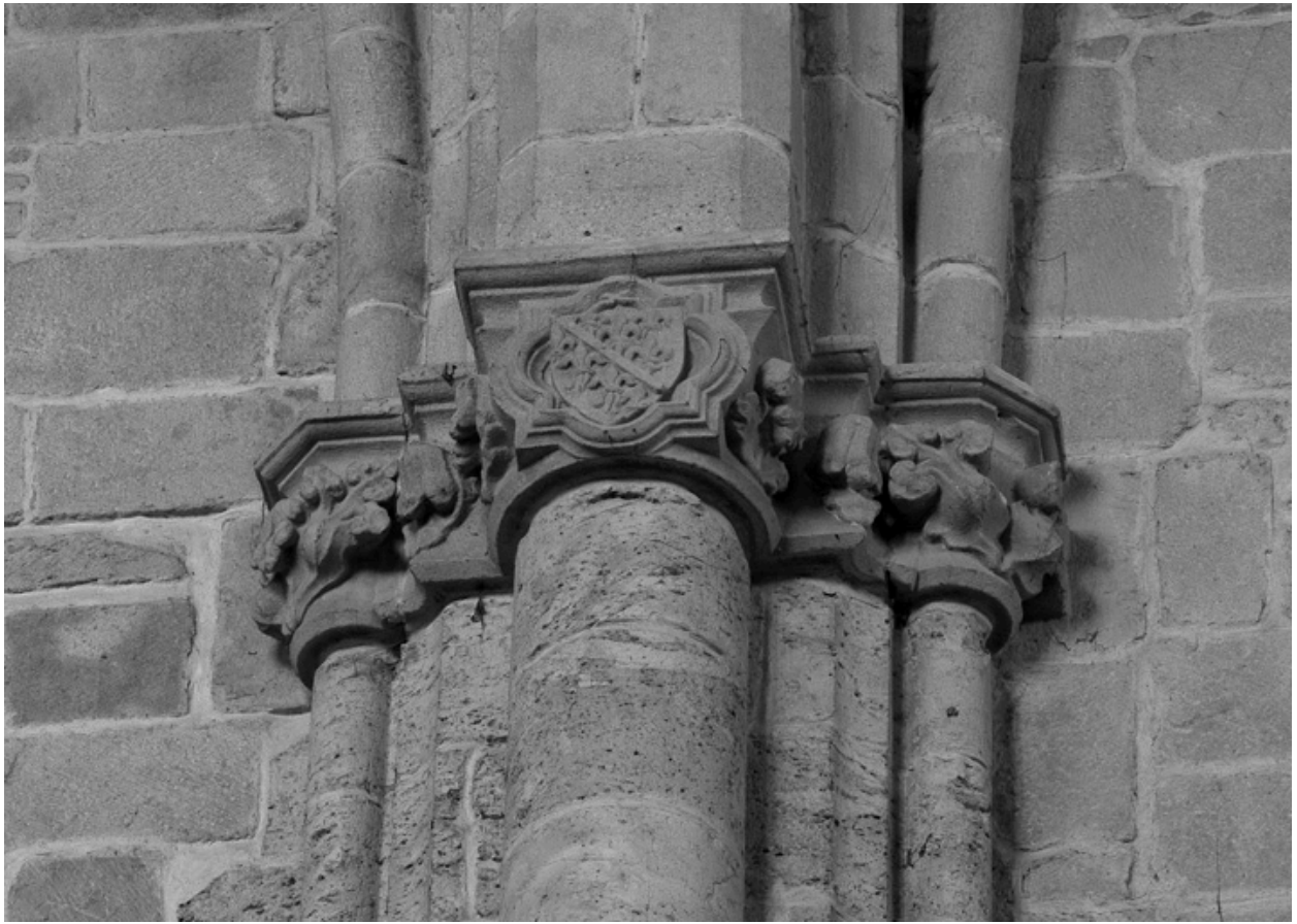
Détail de chapiteaux : support entre les travées II et III, côté sud (armoiries de Louis II).
