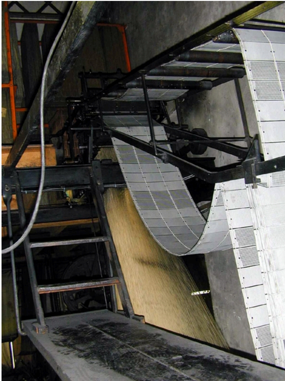
Installation carton : partie haute
