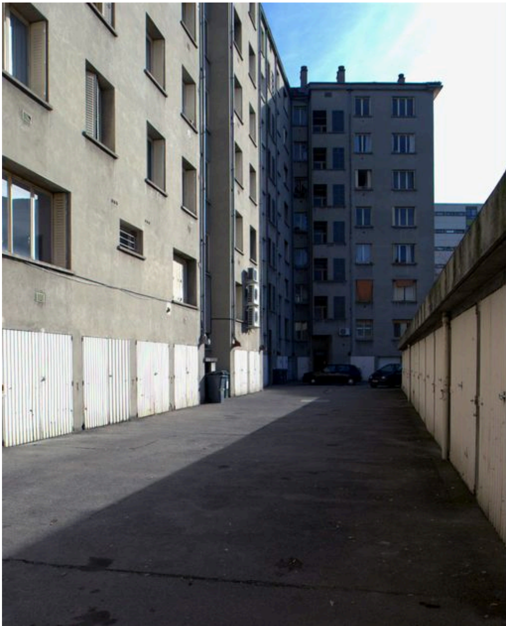
Elévations postérieures, garages et cour
