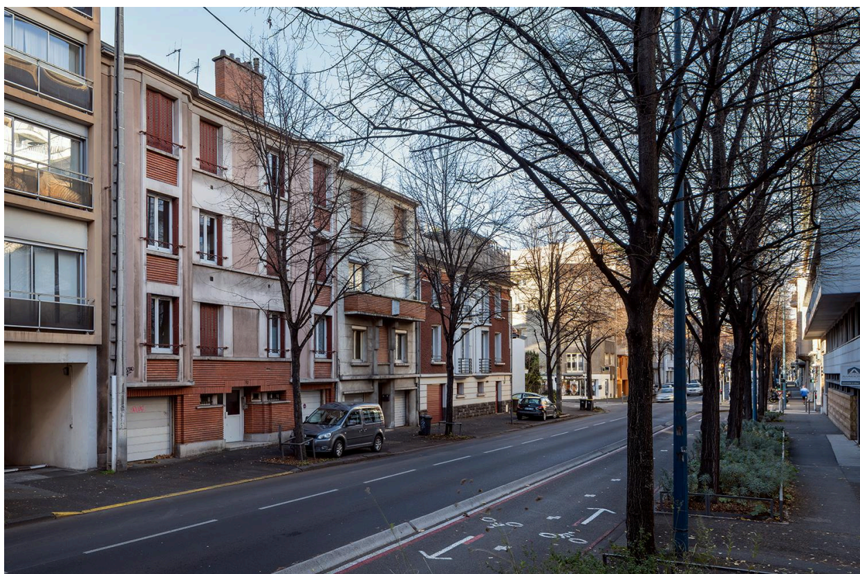
Façades sur le boulevard Aristide-Briand
