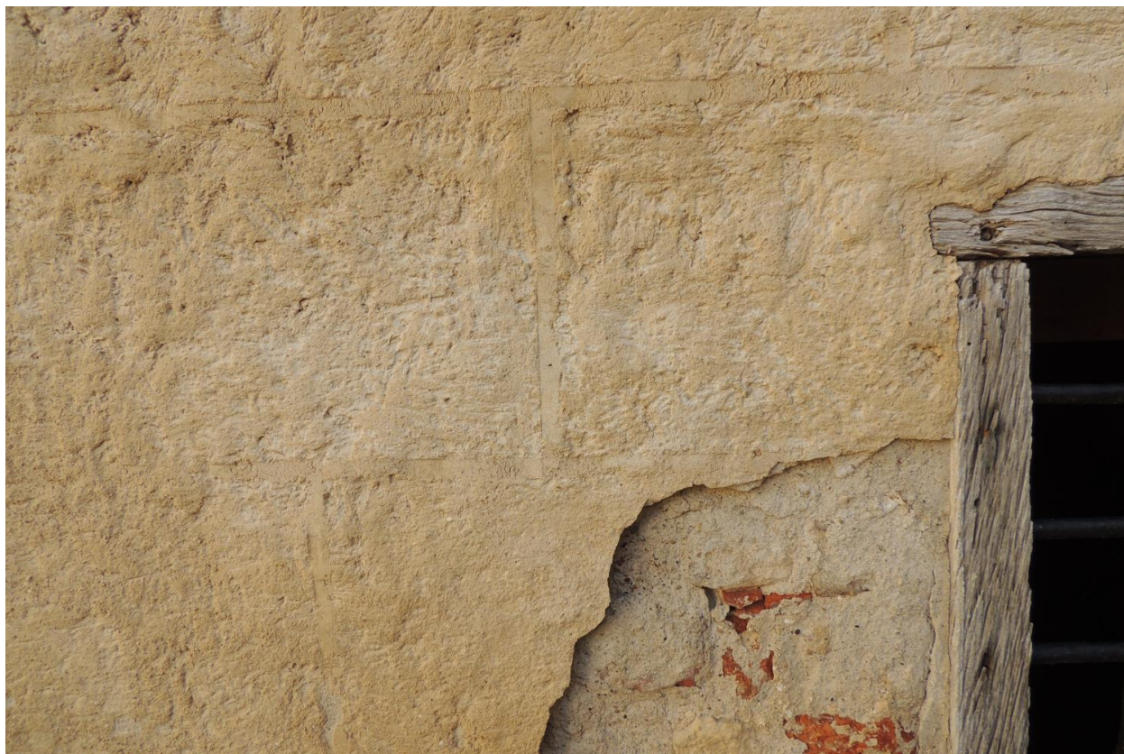
Élévation nord, détail de l'enduit de faux appareil.
