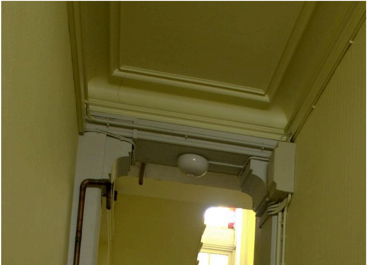
Plafond du vestibule
