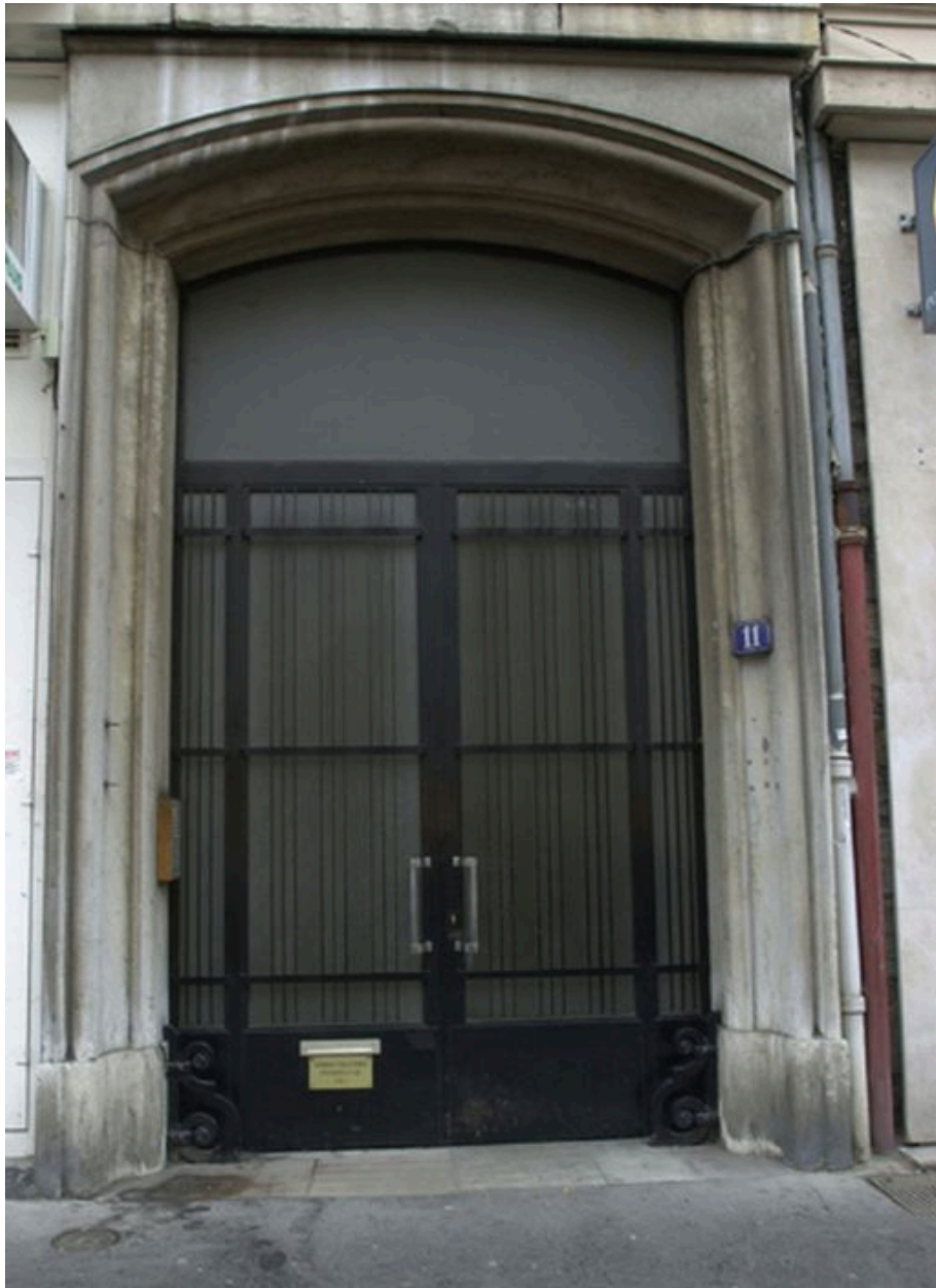
Vue générale de la porte d'entrée
