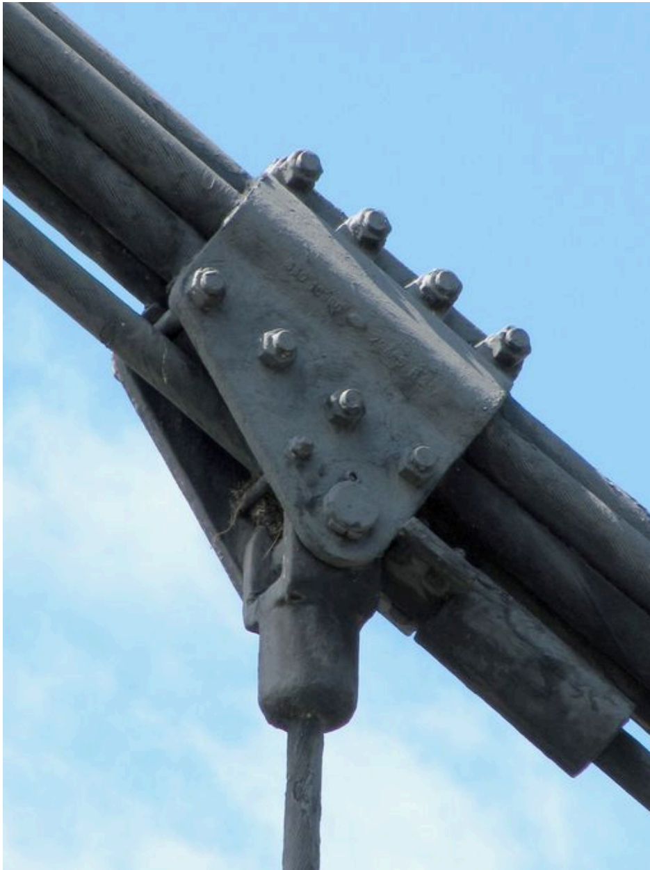
Câble porteur, vue de détail : raccord avec une suspente
