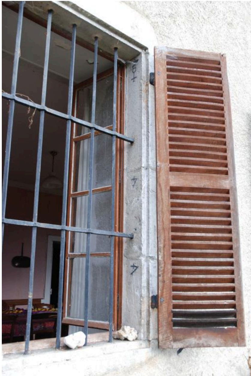
Façade sud du corps de bâtiment principale, détail d'une baie du rez-de-chaussée. Intrados de la baie numéroté.
