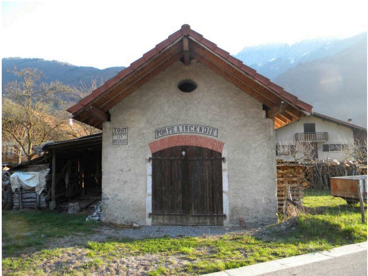
Vue générale du pignon en façade principale.
