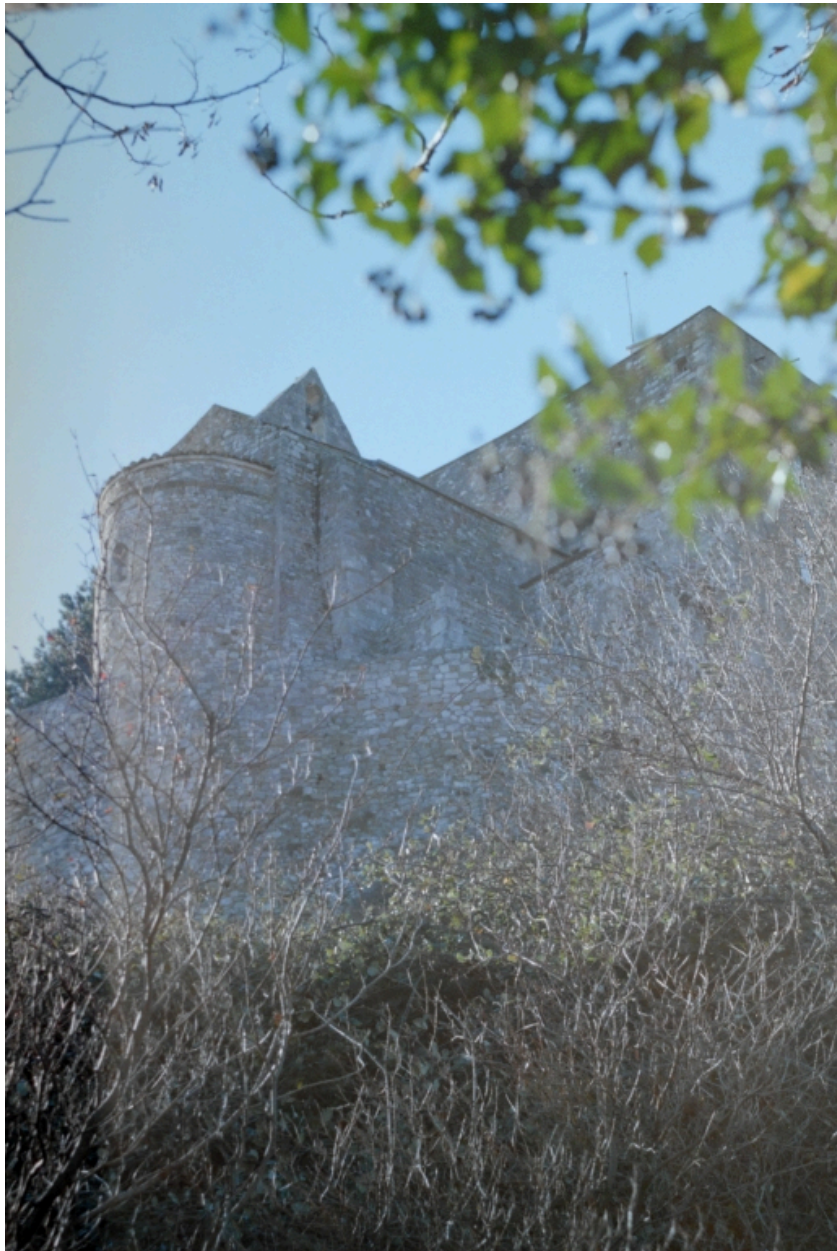
Vue extérieure prise du nord-est.
