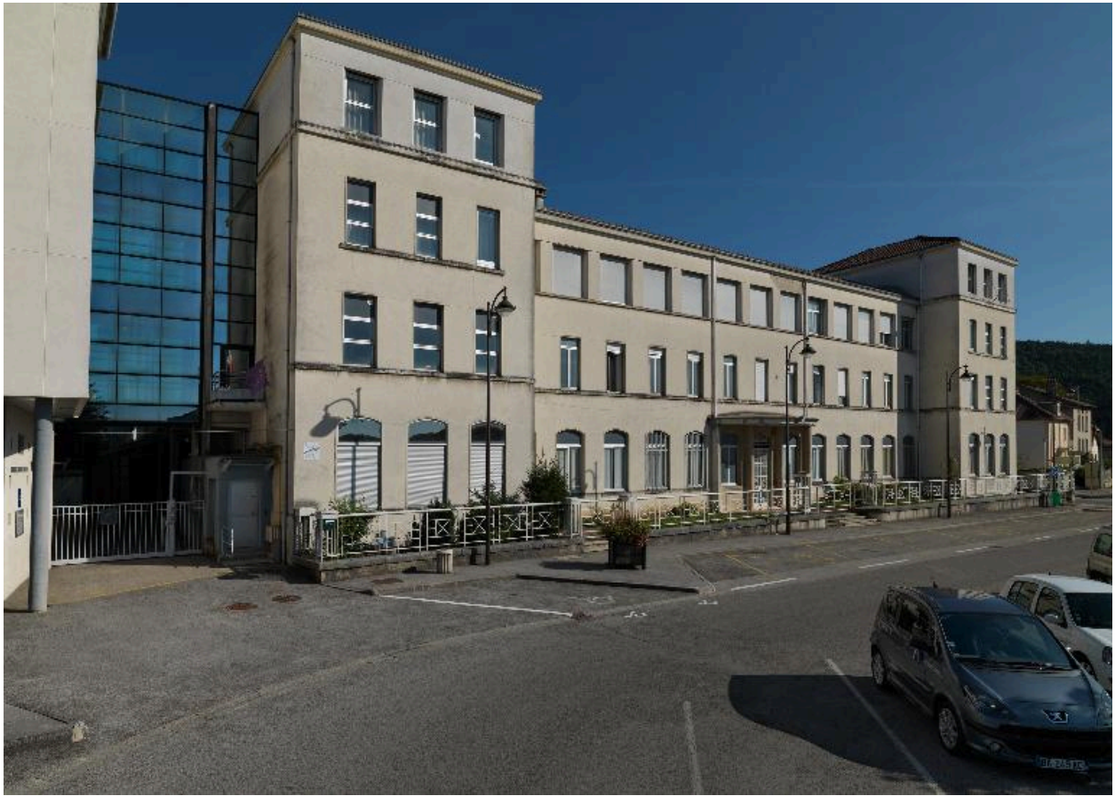
Élévation principale, depuis le nord-ouest
