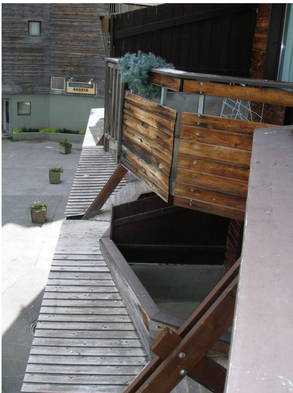
Façade est, détail des garde-corps en bois des balcons inférieurs
