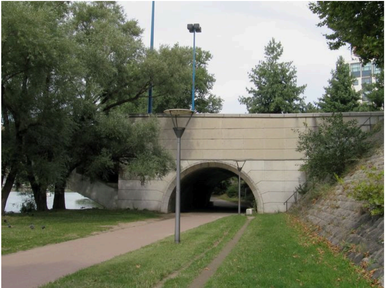
Culée passante gauche, face aval, vue générale (depuis la rive gauche)
