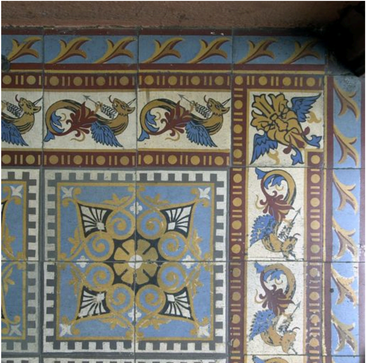
Vestibule, détail du carrelage
