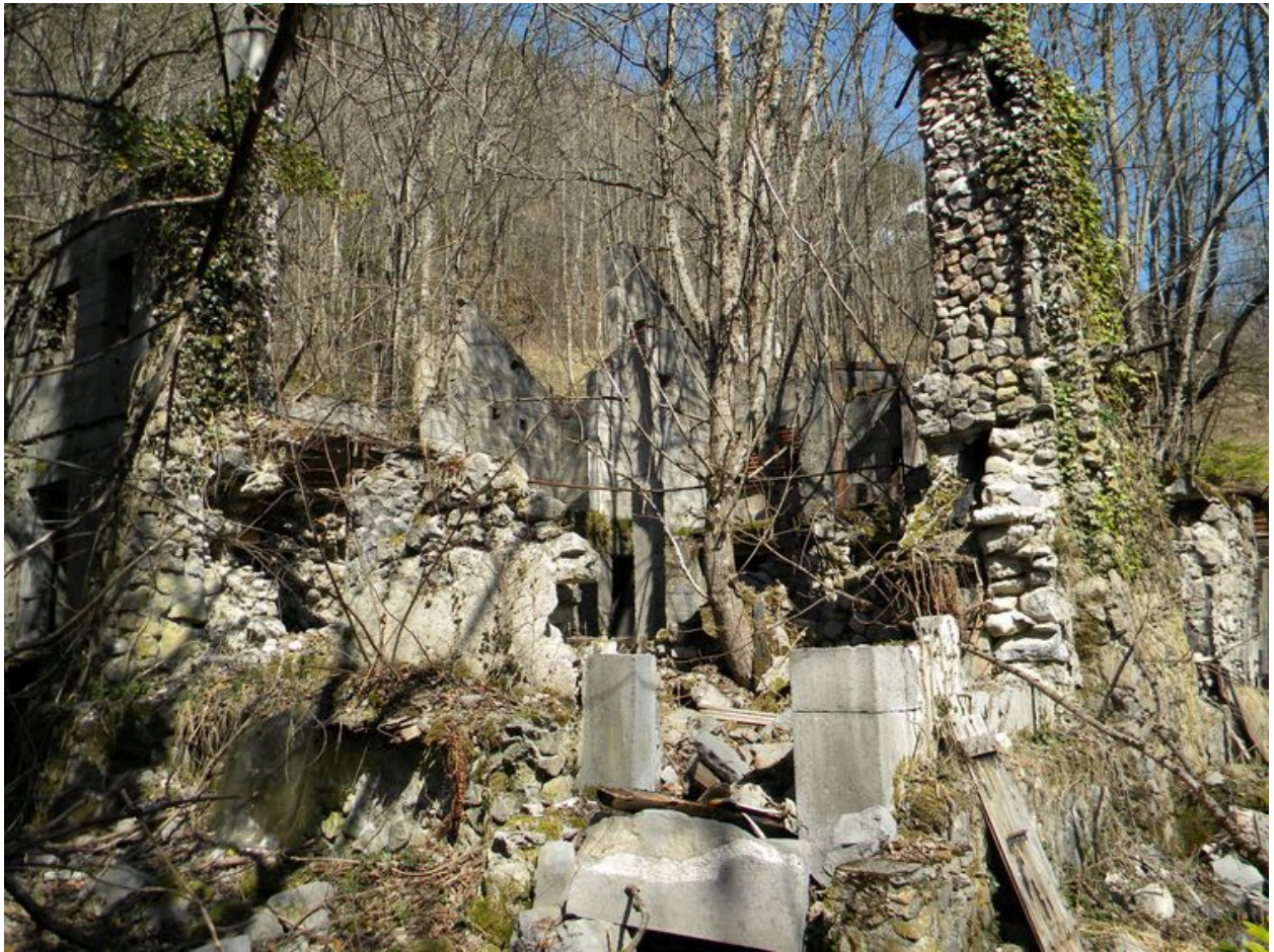
Vue des vestiges d'une maison reconstruite.
