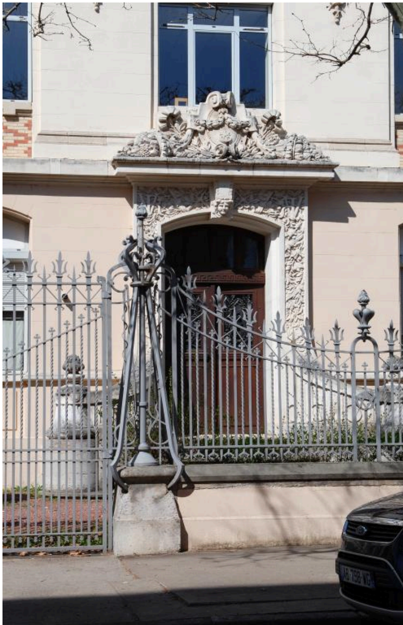
Ancienne entrée principale : détail de la porte
