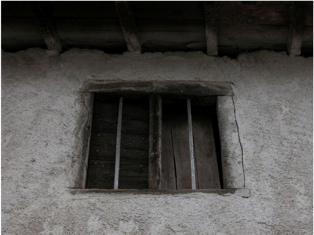
Détail d'une fenêtre haute de la dépendance transformée en logis.
