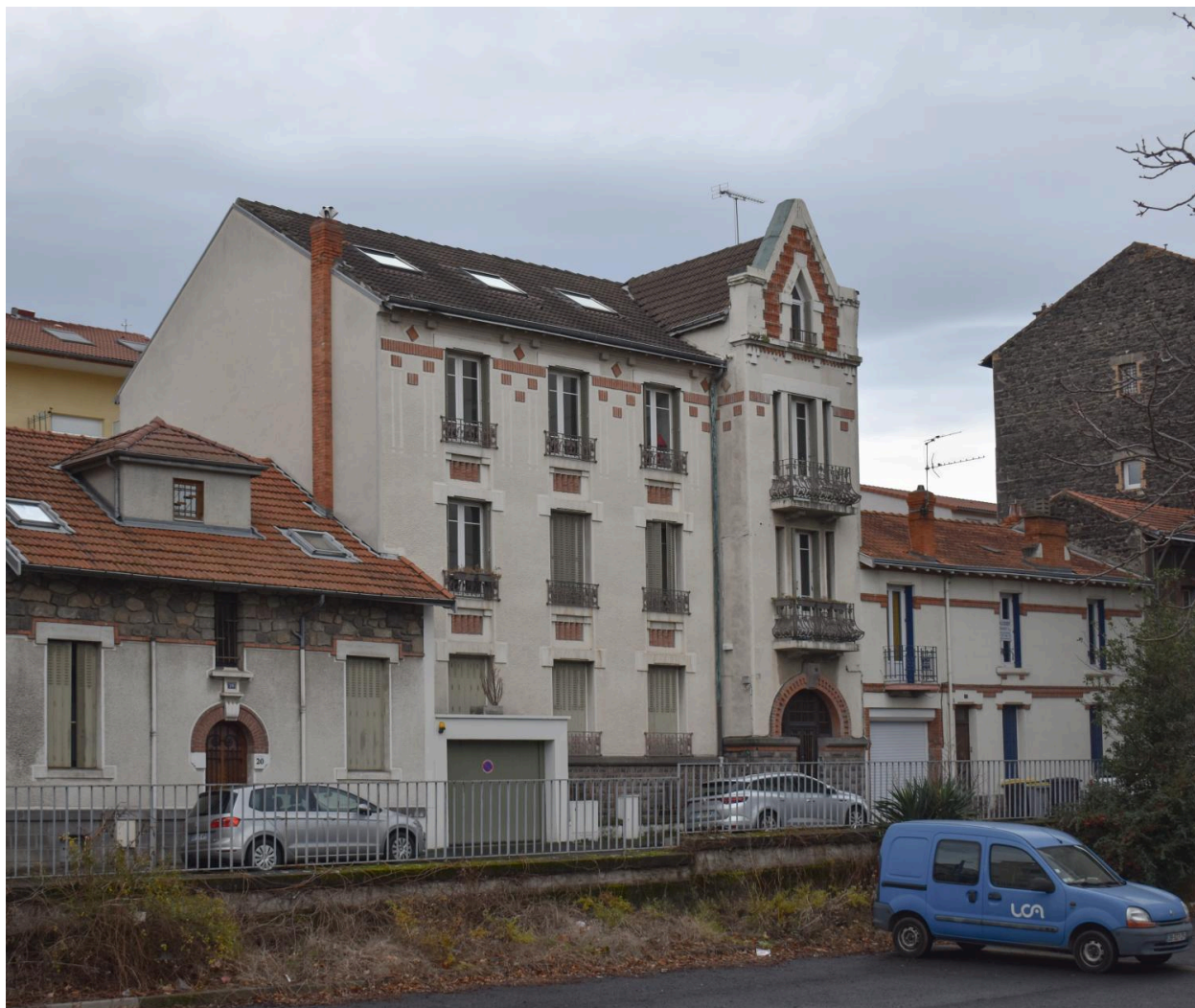
Comparaison. Façade 18 rue Raynaud, Pincot architecte
