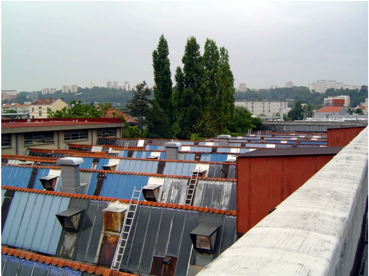
Toiture des ateliers lampes, vue sud-ouest.
