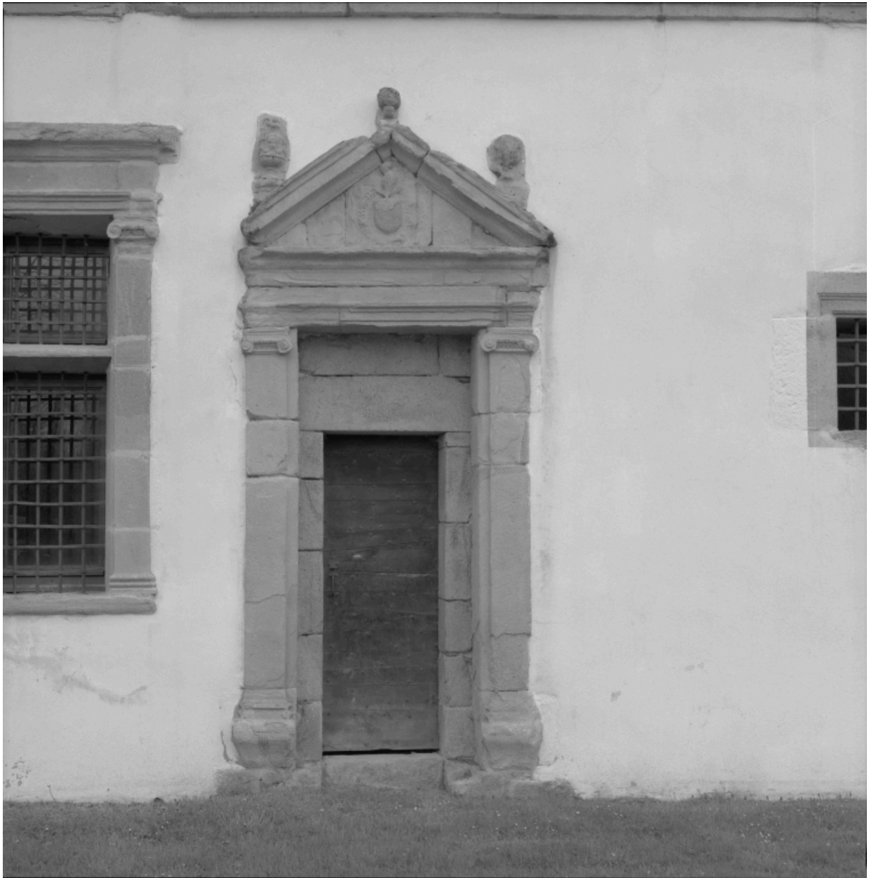
Bastion sud-ouest : détail de la porte du rez-de-chaussée ouvrant sur le jardin.
