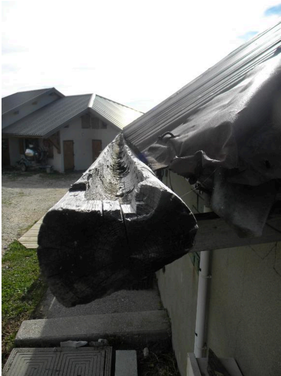
Vue d'une gouttière en bois.
