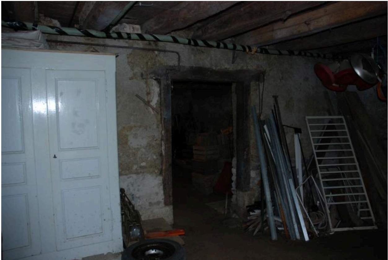
Vue intérieure : mur de refends en pisé.
