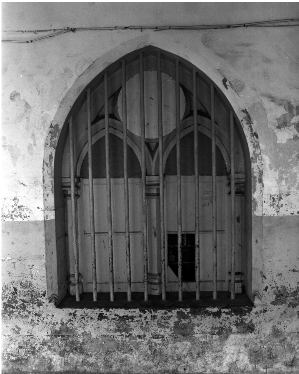
Cloître, détail d'une baie à deux formes et tympan à jour (ici le jour est obturé) dans le mur de la galerie est.
