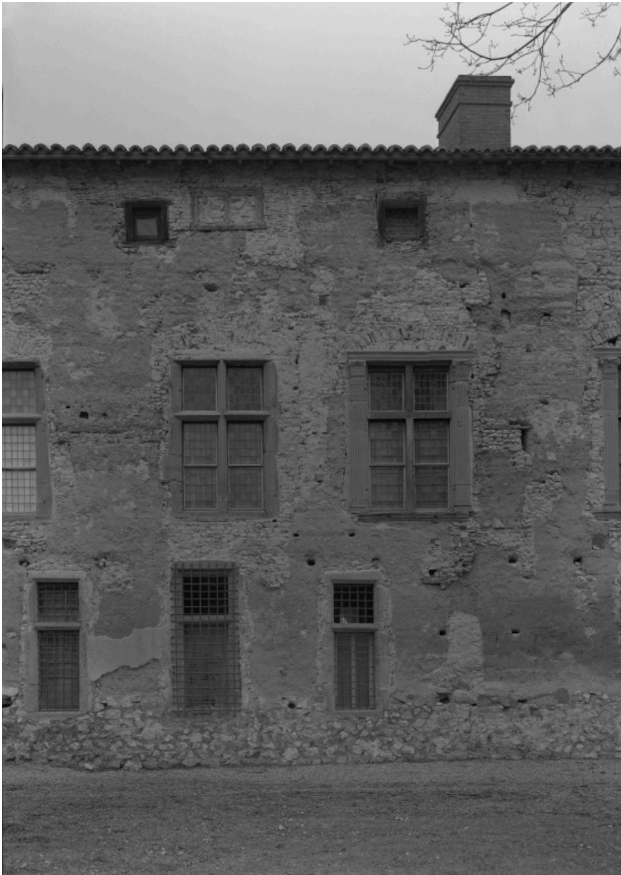
Façade sur jardin du corps de galerie après décroûtage, partie centrale en pisé du corps primitif.
