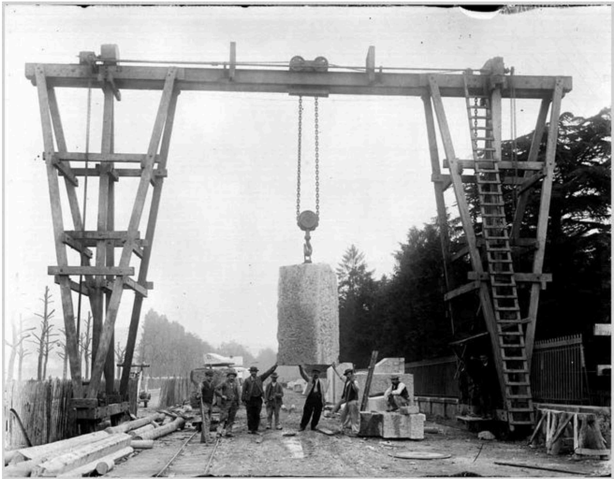
La construction du pont de la Boucle. La pose des maçonneries des piles. [1902]. 1 photogr. : n. et b. (AM Lyon. 15 Ph 1799)
