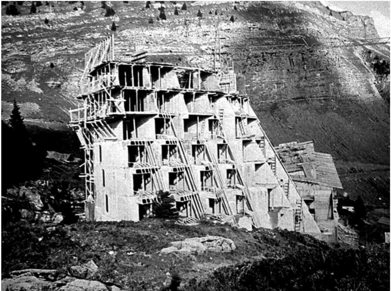
Vue du chantier de l'hôtel. Photogr. 1965 (A. Office du tourisme d'Avoriaz)
