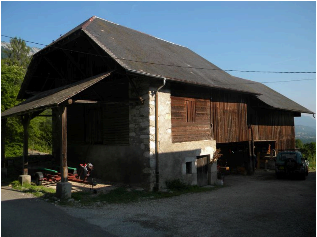
Vue d'un bâtiment agricole à Marceau-dessus (2008 A1 39).
