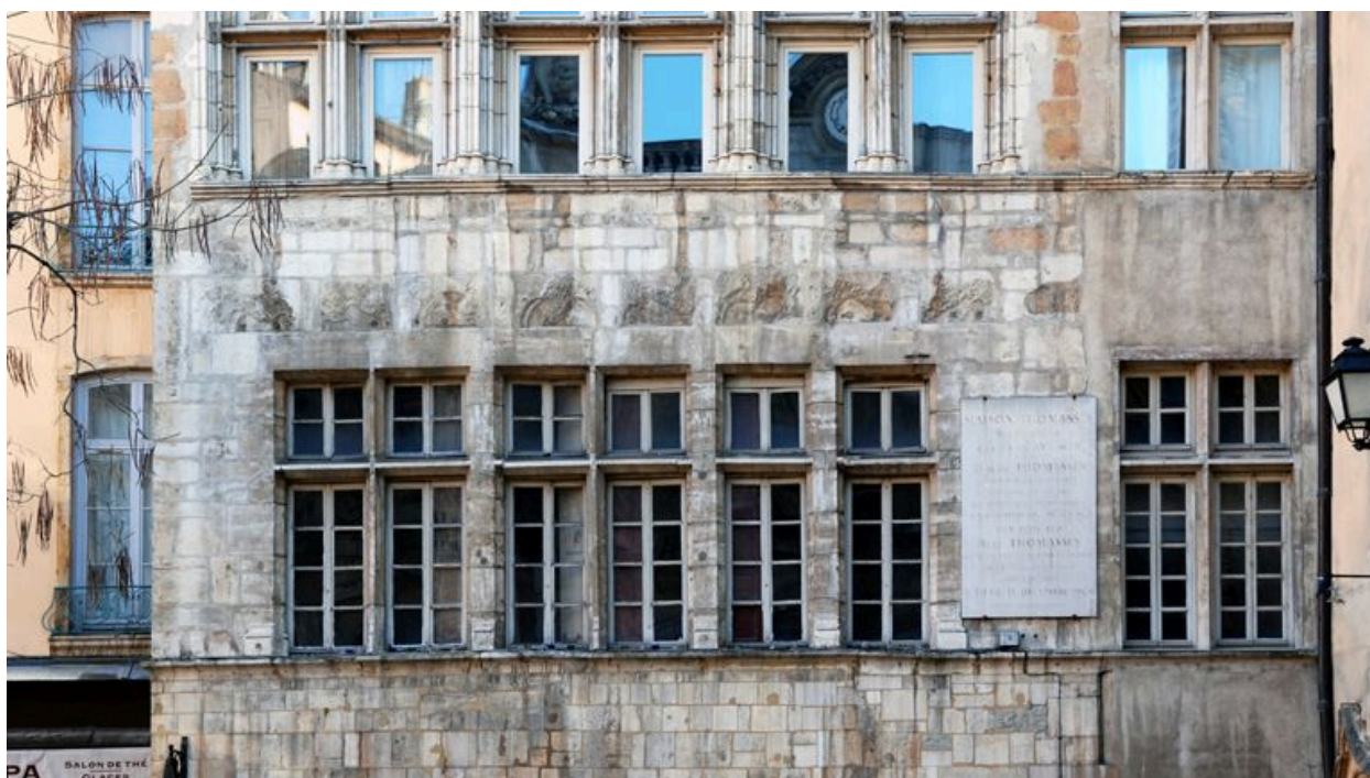
Détail des baies du 1er étage
