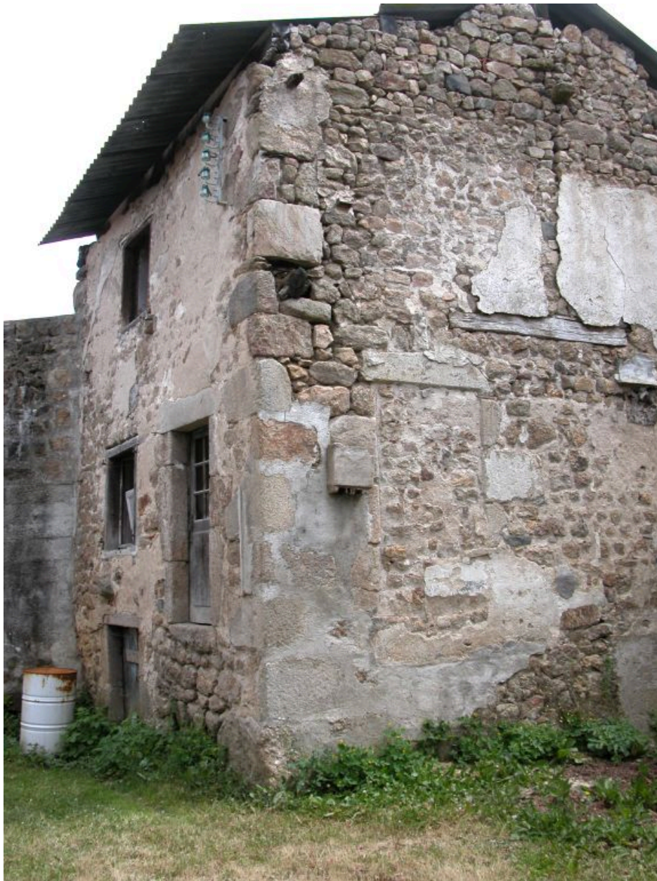
Maison, ferme (1986 AH 154), vue d'ensemble.
