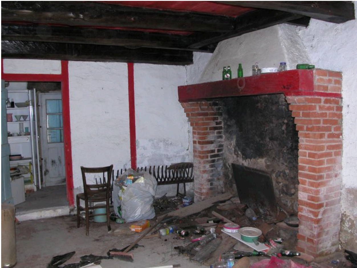
Vue générale intérieure de la cuisine avec cheminée.
