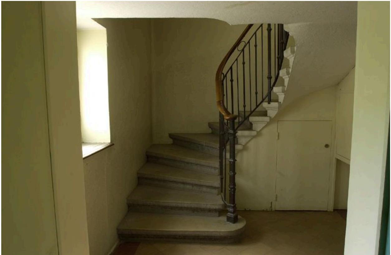
Rez-de-chaussée : départ de l'escalier de service
