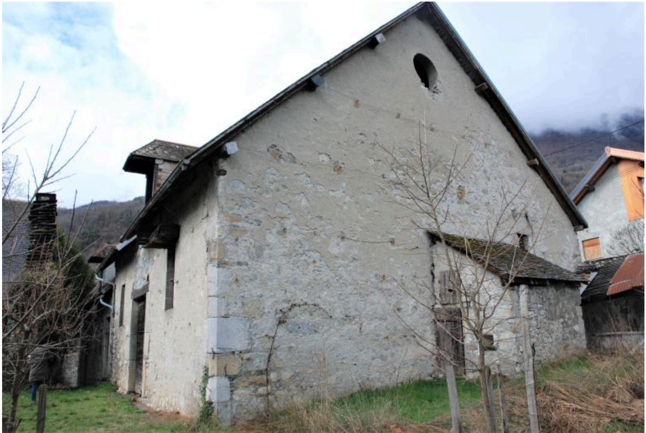
Bâtiment abritant les communs (étables, granges). Elévation du mur pignon est, vue d'ensemble.
