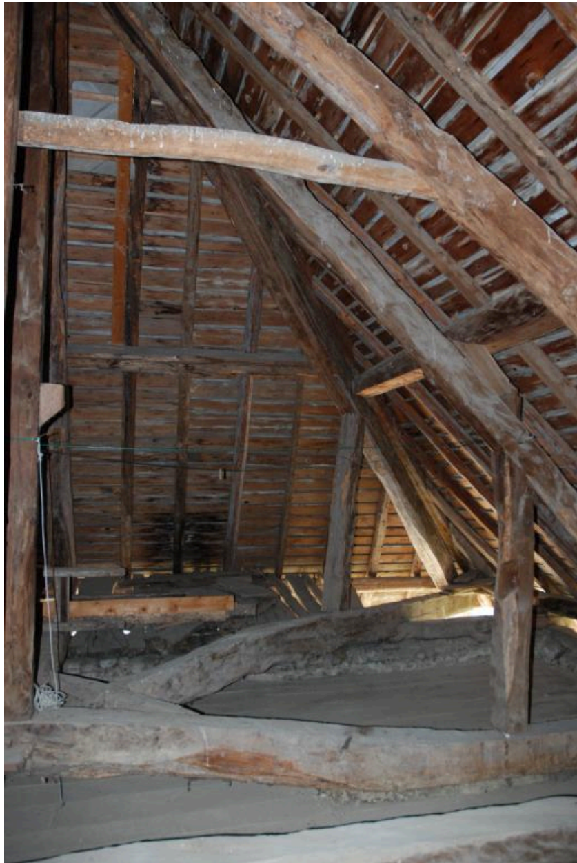
Vue intérieure de la charpente.
