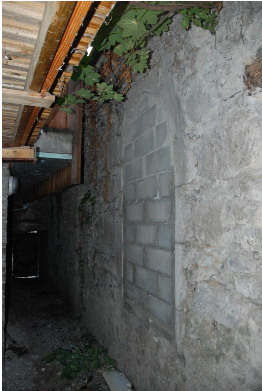
Vue extérieure des vestiges du collatéral est, mur est : 4e fenêtre (murée).
