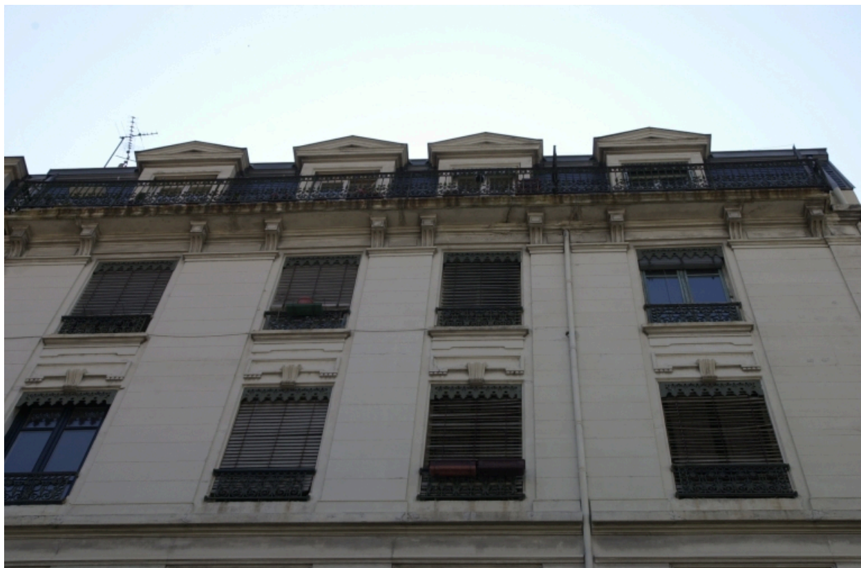
Détail des niveaux supérieurs
