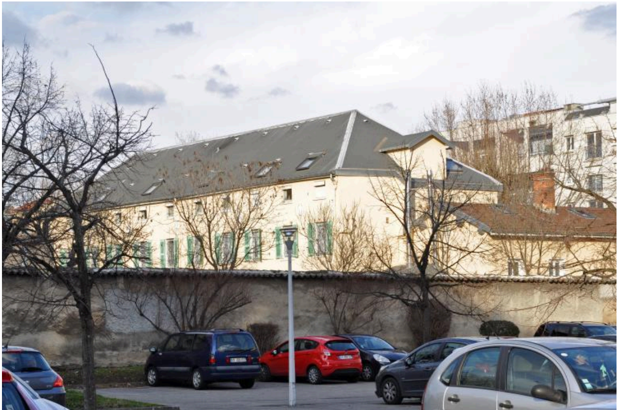
Aile sud, vue partielle de l'élévation postérieure
