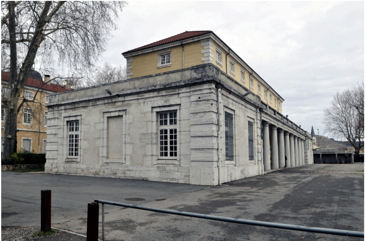
Bâtiment C. Façade depuis le parc : édicule au sud ouest.
