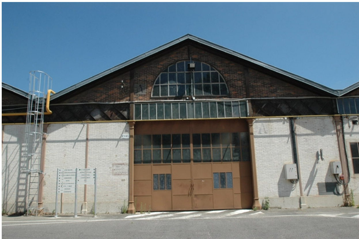
Façade halle (bâtiment 43)
