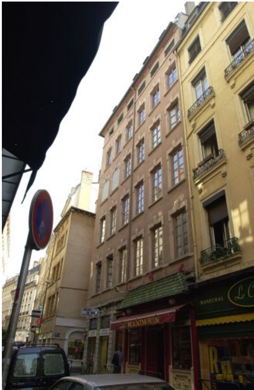
Façade principale sur la rue Lanterne
