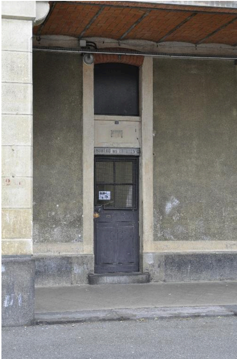
Bâtiment A. Porte et imposte, rez-de-chaussée sur cour
