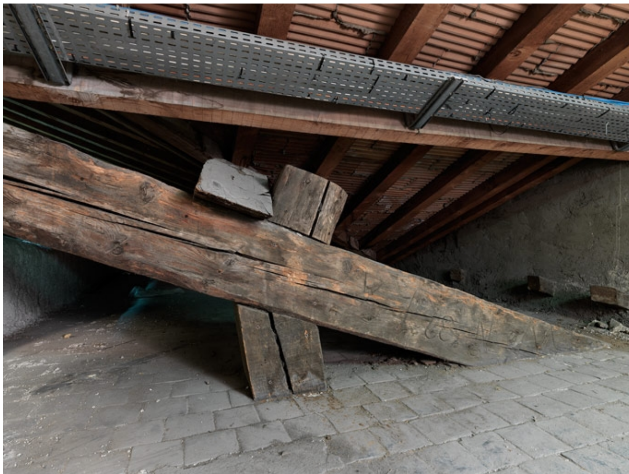
Bâtiment B. Détail de la charpente
