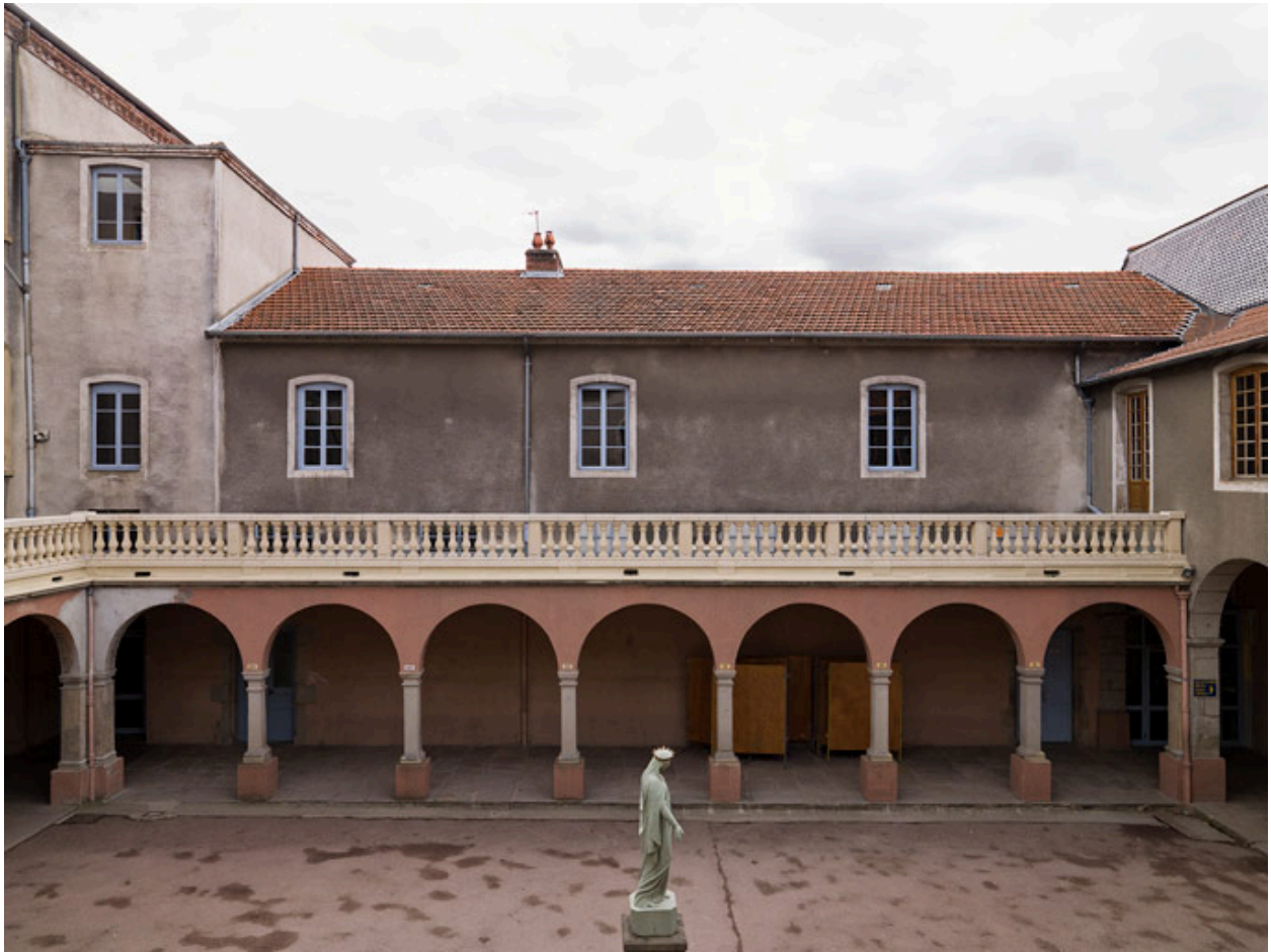
Bâtiment B, élévation sur la cour d'honneur.
