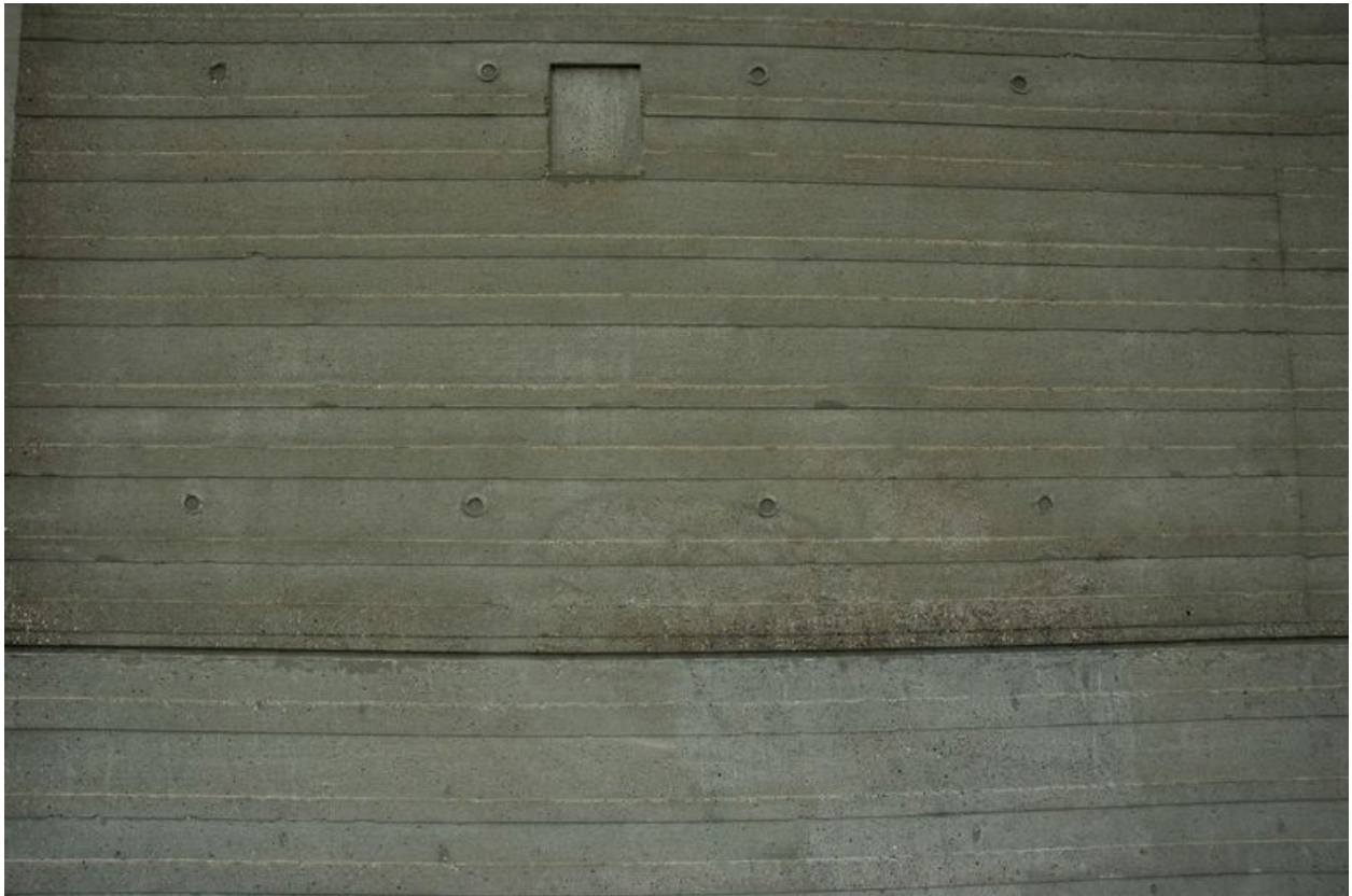
Détail du béton brut de décoffrage
