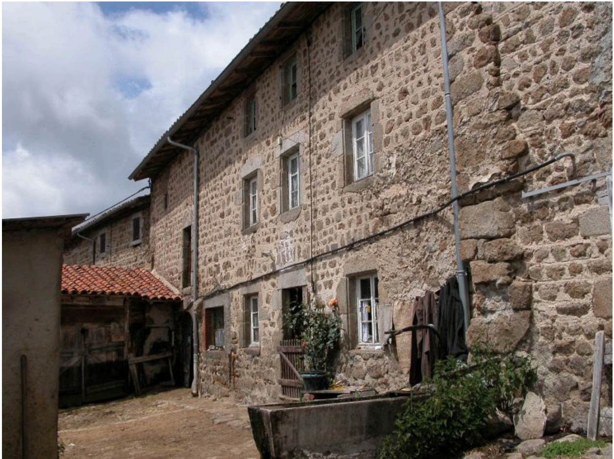
Vue d'ensemble de la façade sur cour.
