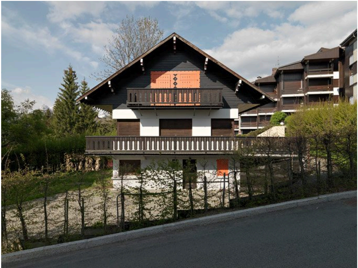
Chalet la Chaumette, 31 route du Téléphérique. Vue depuis le sud
