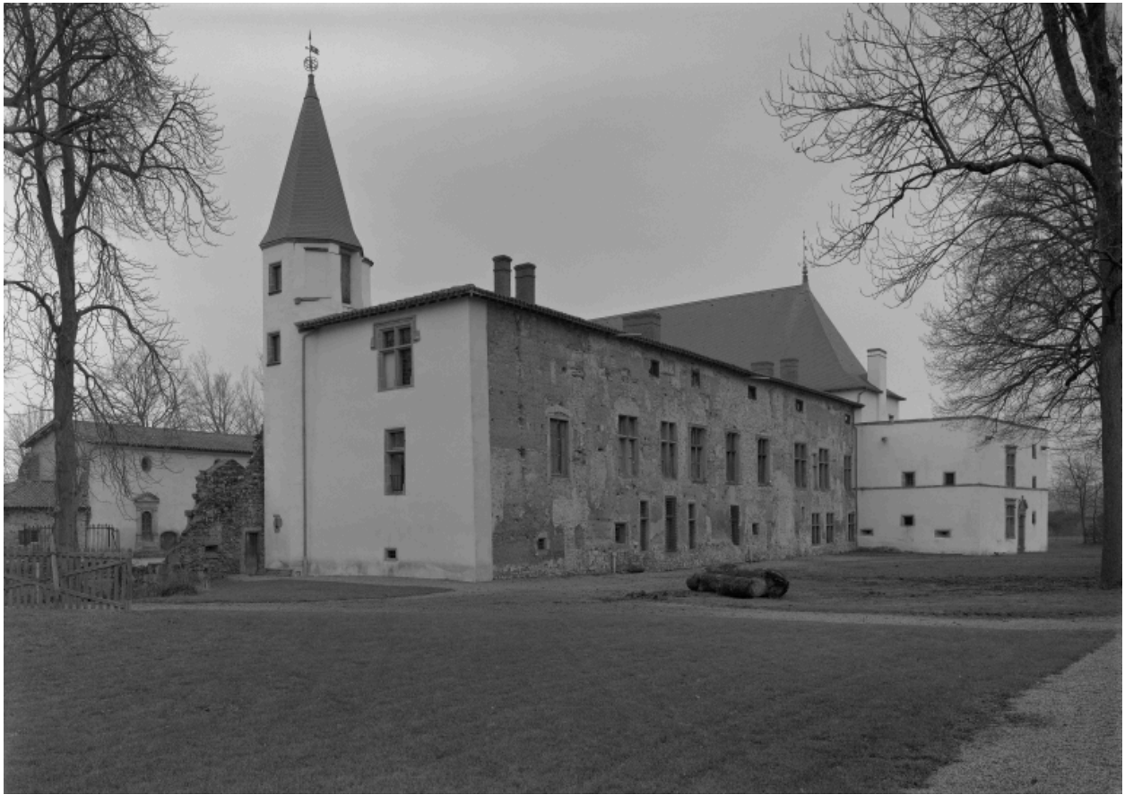
Vue générale de la façade sur jardin du corps de galerie, après décroûtage.
