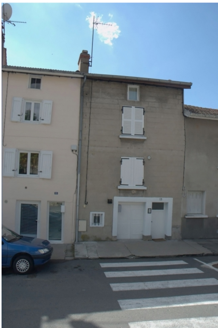
Îlot 3. Sordet (rue du) 13. Vue générale de la façade sur rue.
