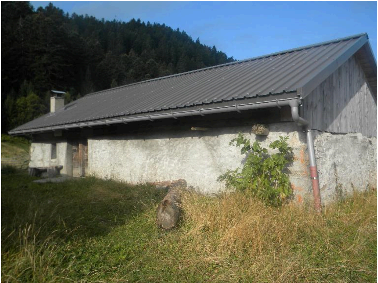
Vue de la façade principale du bâtiment comprenant l'habitation.
