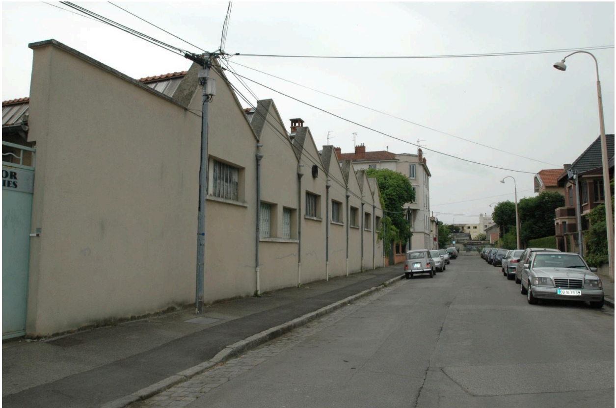
Vue Sud de la façade ouest
